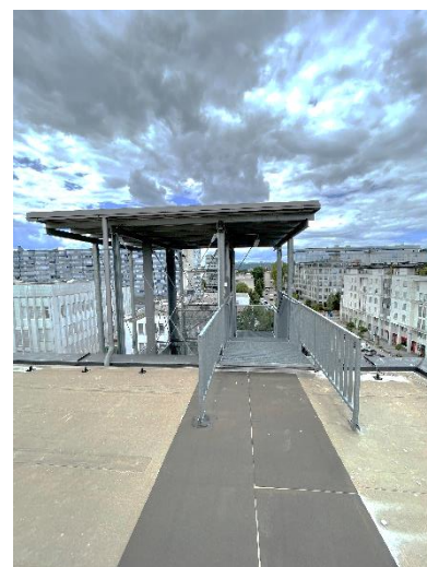
Povezava stopnišča s streho.
