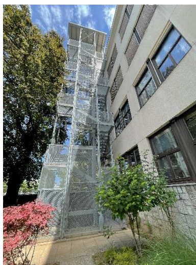
Zunanje stopnišče z vidno prvo linijo oken.
